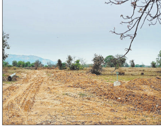
गैस पाइप लाइन के लिए खोदे गए गड्ढे।
